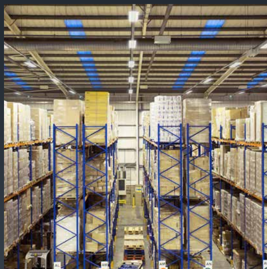
Effiziente Beleuchtung für Logistik und Lagerbereiche – mit ovalem Lichtkegel für eine bessere Ausleuchtung der Gänge.
